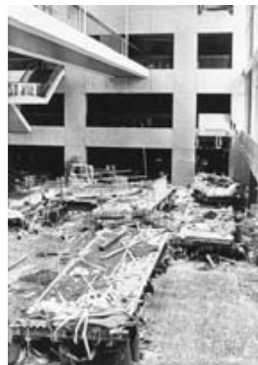
FIGURA 12-1 Un piso elevado se colapsa en un hotel de Kansas City en 1981. En el ejemplo 12-9 se considera cómo un sencillo cálculo de física pudo haber prevenido la trágica pérdida de más de 100 vidas.
