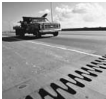
FIGURA 17-3 Juntas de expansión en un puente.
